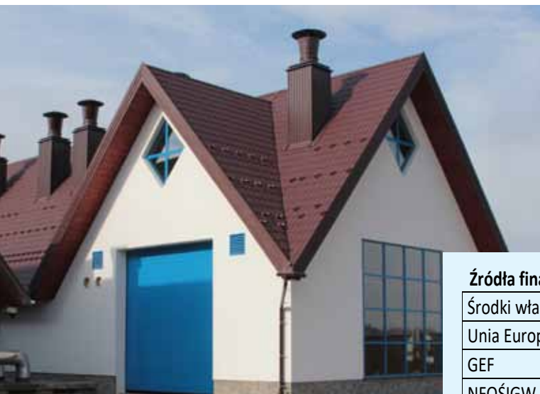
Rozbudowa Ciepłowni Geotermalnej - stacja trafo
