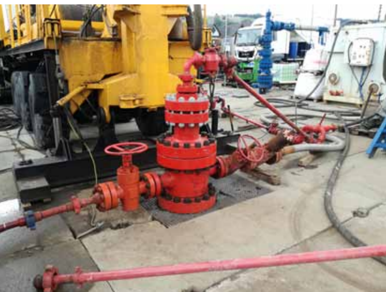
Zabieg intensyfikacji wydobywania odwiertu produkcyjnego Bańska PGP-3
